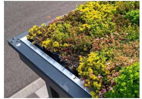
Fahrradunterstand mit Dachbegrünung
