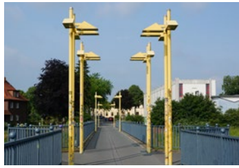
Fußgängerbrücke über die Ems mit Bestandsleuchten
