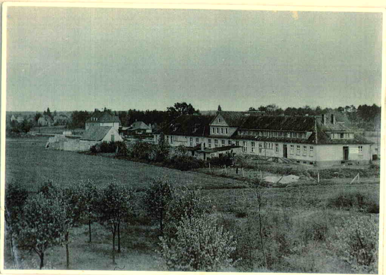
Rückseite des „Deutschen Hauses“ früher Verwaltungs- gebäude des Munitionslagers Reckenfeld.
